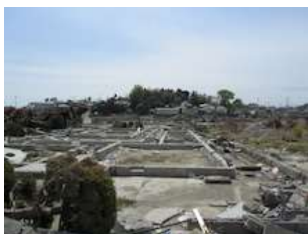
名取住宅街(津波により住宅が押し流されて基礎コンクリートしか残っていない)
