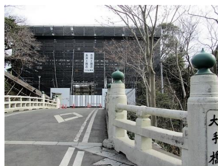
弘道館から大手橋方向の光景(中央奥は建設中の大手門、建設費約 4 億円) (桜井撮影)
