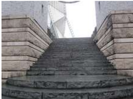
シンボルタワーへの階段拡大
