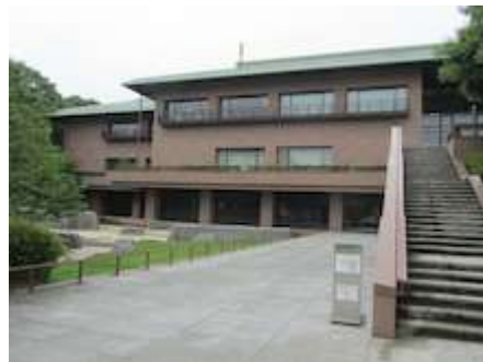
入口の2階への階段(北側)
