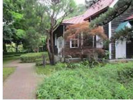
中村彝アトリエ建屋(内部案内はボランティアが担当)(常にきれいに管理されている)(建屋は東京から移設)
