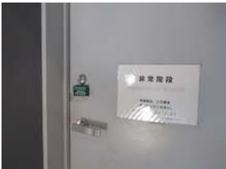
シンボルタワー展望台 6(非常階段。ドアは、通常時には、ロックされているものの、青いプラスチック部を破ると、ロックが外れ、ドアが開く)
