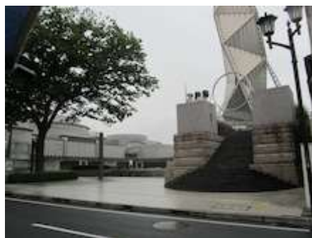
シンボルタワーへの階段(シンボルタワー全体の構造設計を調査中、特に、基礎工事方式)
