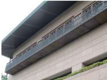
3F 北側テラス
